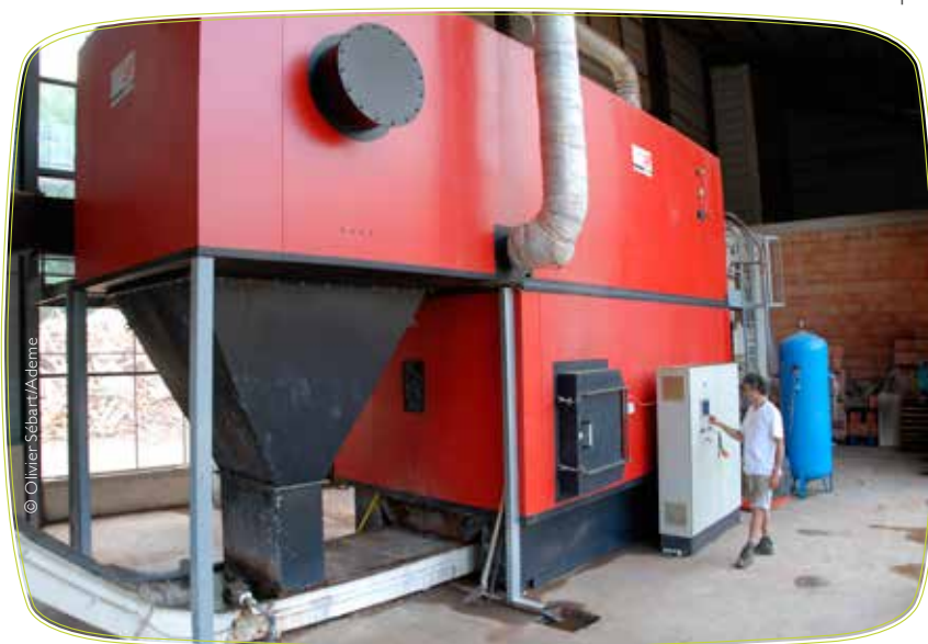
Cette chaudière pour bois déchiqueté a une puissance de 3 000 kW (serres Merland - Ardèche).
